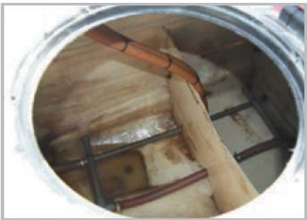
Грязь в баке опрыскивателя через 3 недели работ
